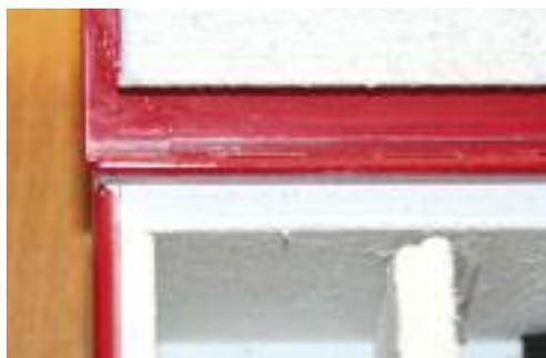
Hier ist zu sehen, dass der Spalt an der Scharnierseite größer sein muss, damit das Scharnier beim Schließen nicht blockiert wird.
