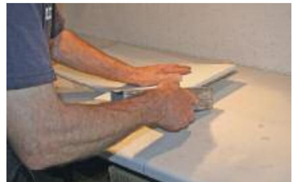
Da die Bruchkanten natürlich nicht glatt sein können, wird geschliffen. Perfekt dafür ist ein Perma-Grit-Schleifklotz, der sich anschließend einfach mit Wasser reinigen lässt.
